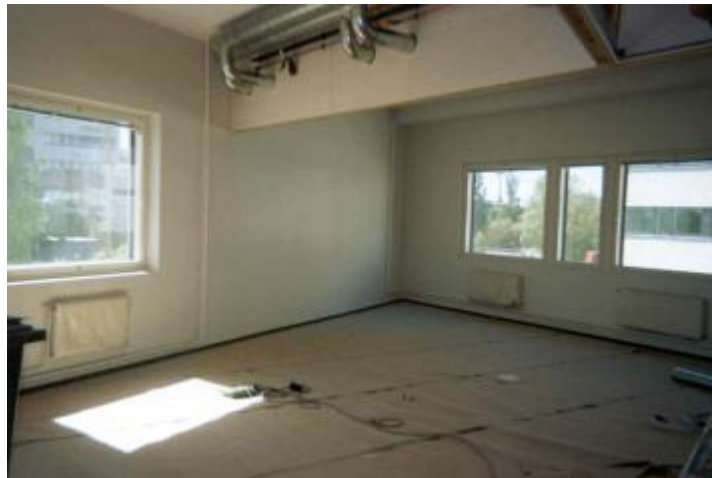
Kuva 6.5. Valokuva muuntamon LM-3 yläpuolisesta tilasta.
