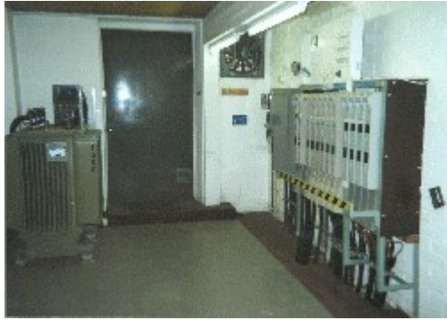
Kuva 6.63. Valokuva muuntamon T486 pienjännitekaapelisillasta ja piirros muuntamon rakenteesta.
