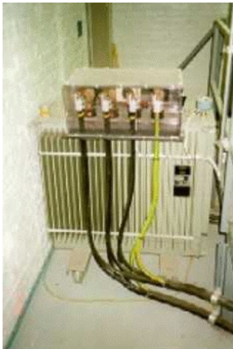
Kuva 6.51. Valokuva muuntamon T53;2 pienjännitekaapelisillasta ja piirros muuntamon rakenteesta.
