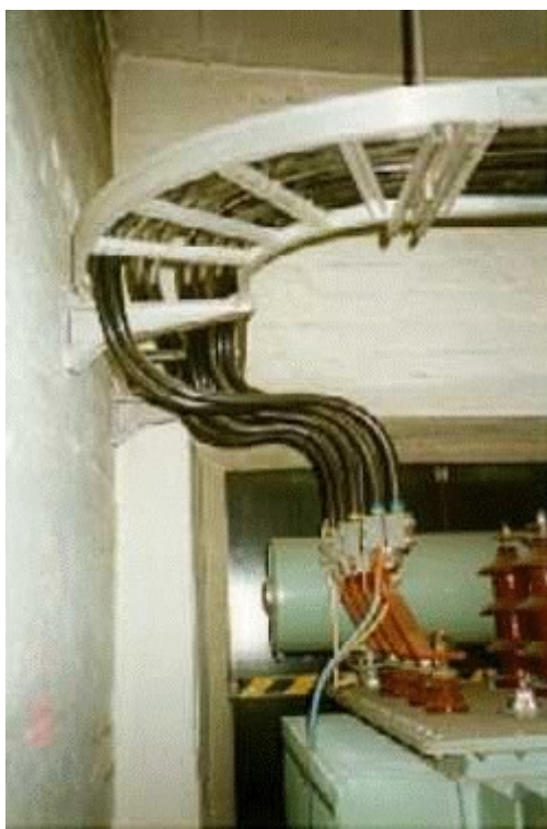
Kuva 6.61. Valokuva muuntamon T994 pienjännitekaapelisillasta ja piirros muuntamon rakenteesta.
