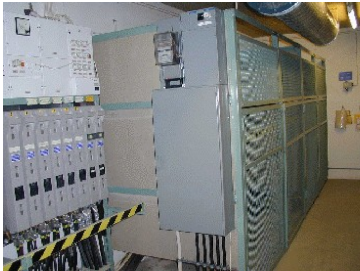
Kuva 6.17. Valokuva muuntamon T573 pienjännitekeskuksesta ja piirros muuntamon rakenteesta.
