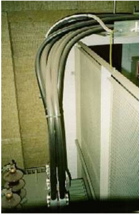
Kuva 6.59. Valokuva muuntamon T1217 pienjännitekaapelisillasta ja piirros muuntamon rakenteesta.
