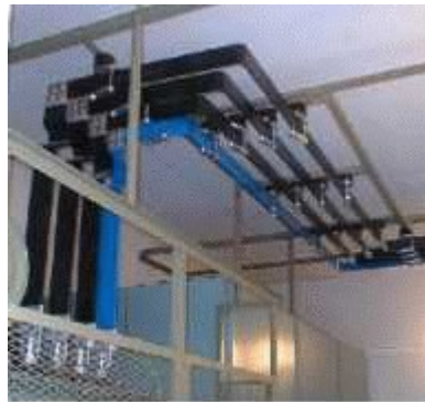
Kuva 6.33. Valokuva muuntamon H2793 pienjännitekiskosillasta ja piirros muuntamon rakenteesta.
